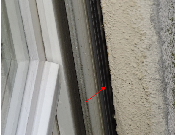
Abb. 10: Hohlraum in Rollladenkasten (roter Pfeil)
