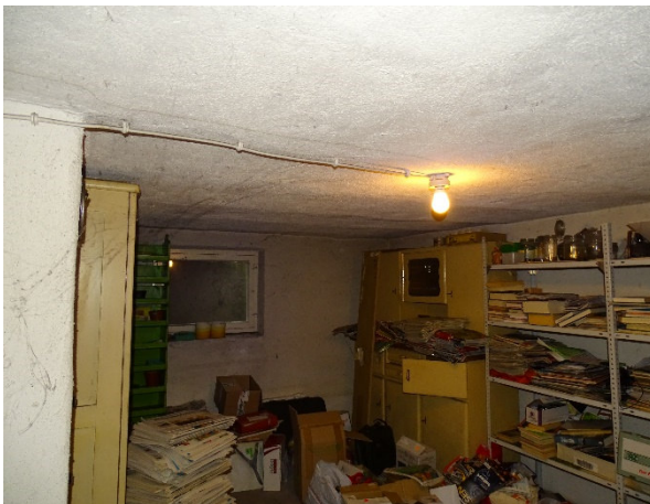
Abb. 8: Kellerlagerraum mit verschlossenem Fenster
